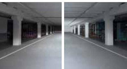
Lux-vergelijking Briq-M E Highbeam 150 Lux (links) / 200 Lux grootlicht (rechts)
